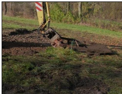
*Fig. 11 : Ajustement des plaques à l'aide du godet*
