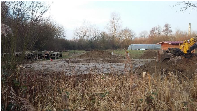
Figure 9 Travaux d'aménagement des bassins aquatiques
